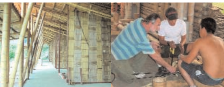
Schulgebäude aus Guadua
