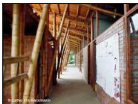
Bambú, materia prima para la construcción del colegio.
